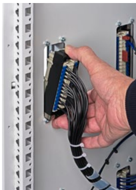
図III-2.19 組立済み取付フレームの 挿入
