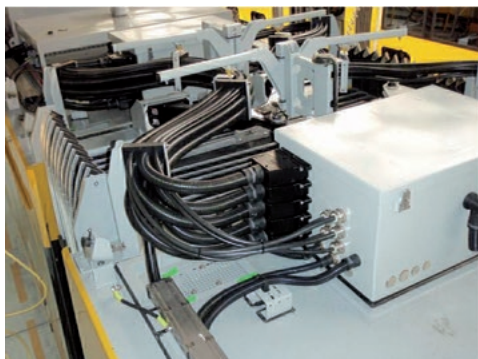
図VII-3.6 屋根に設置された車両 間接続
