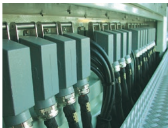
図II-9.2 電流コンバータに使用されるセンターロック機構のHan®B
