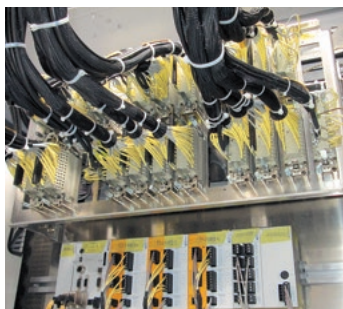
図II-9.3 Han® EEおよびHan® ESSと グリップパネル
